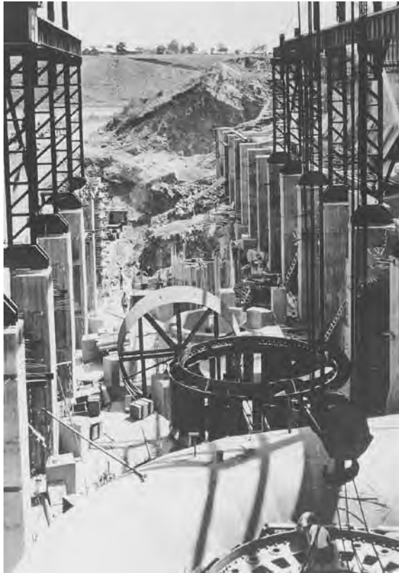
FIGURA 14.5 A barragem de Jinja, em Uganda. (Foto: Topham, Londres.)
