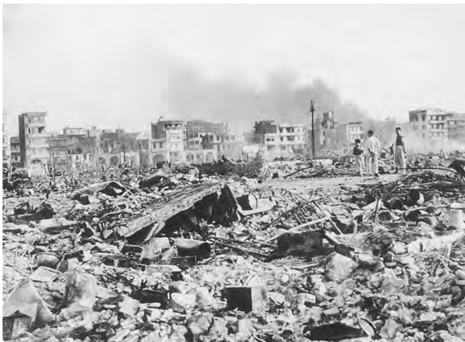
FIGURA 6.4 Port-Saïd, na zona do canal: a destruição causada pela guerra de 1956. (Foto: Popperfoto, Londres.)
