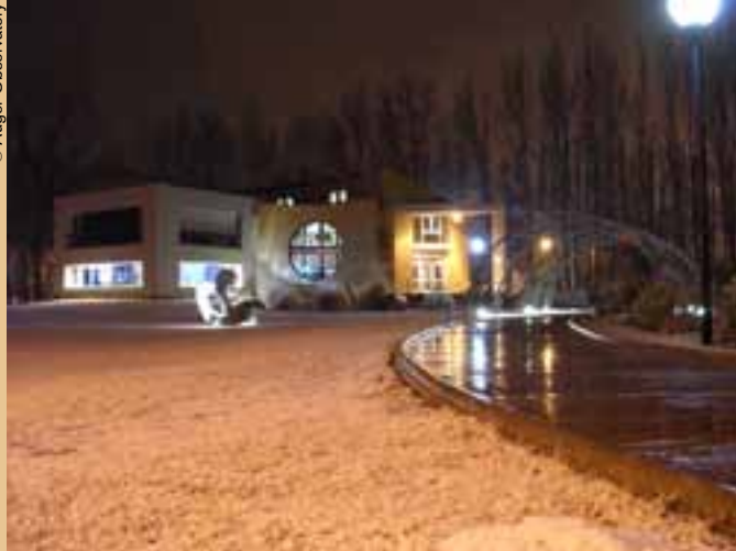
Bâtiment administratif de l'Observatoire.
