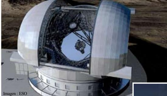
como la óptica activa (deformación de la superficie del espejo) y la óptica adaptativa (corrección en tiempo real de las deformaciones de la imagen debidas a la atmósfera), permitiendo un ángulo de imagen jamás alcanzado desde la Tierra.
