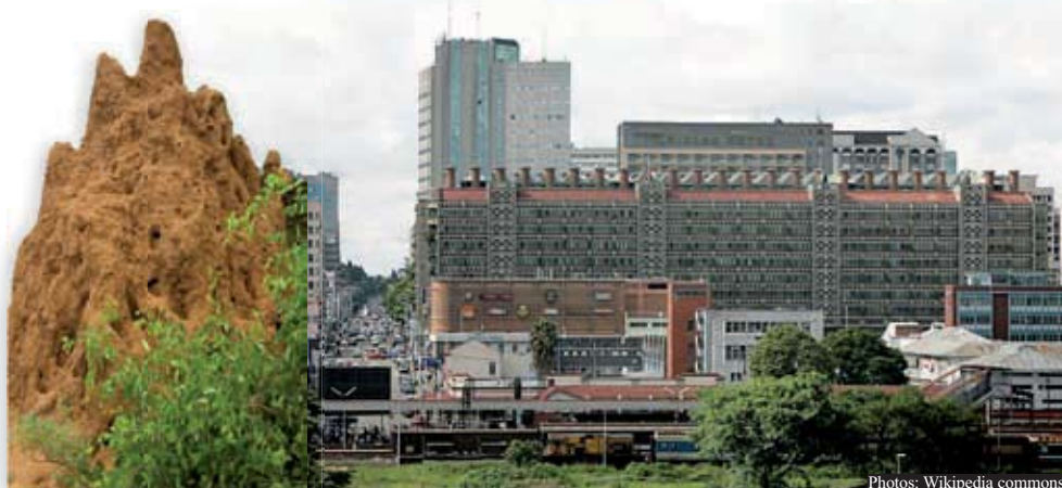
Construit en 1996, le bâtiment de l'Eastgate Center au Zimbabwe a été conçu d'après les termitières qui maintiennent leur température stable à l'intérieur même quand la température extérieure varie entre 3°C et 42°C. Comme elles, ce centre commercial pratique le rafraîchissement passif : la chaleur accumulée durant la journée est évacuée la nuit par de larges cheminées qui attirent de l'air froid à l'intérieur du bâtiment. Le centre commercial n'utilise que 10 % de l'énergie d'une construction climatisée conventionnelle, réduisant ainsi les coûts d'énergie et les émissions de CO 2 .
