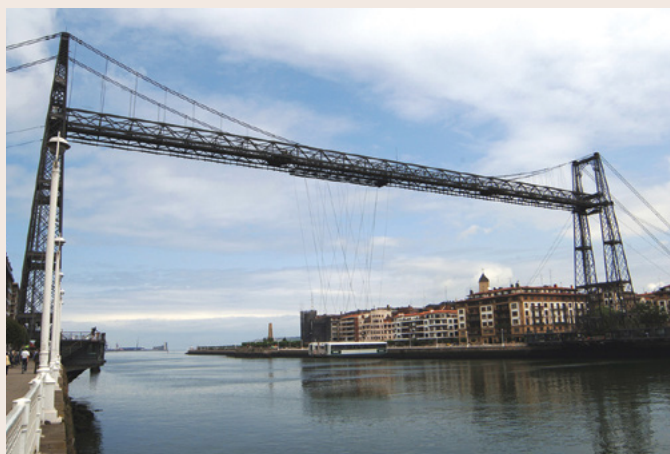
Ponte Vizcaya (Espanha)
