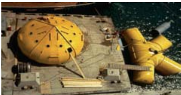
Avant d'être immergé, le village de Précontinent II est assemblé en surface. La maison des océanographes, en forme d'étoile de mer, est à l'eau, prête à être « coulée » à 10 m de profondeur. Sur le quai, le hangar de la soucoupe plongeante fini d'être construit
