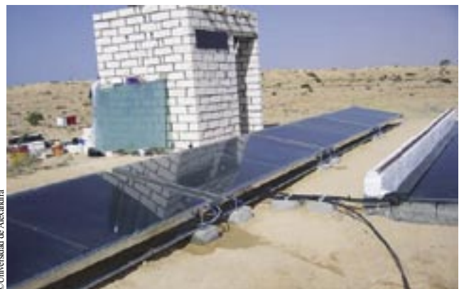
Dos días después, el sistema está prácticamente listo para funcionar. Se añadirán otros paneles para incrementar la capacidad y se construirá un muro para proteger el material de las tormentas de arena y de toda intrusión
