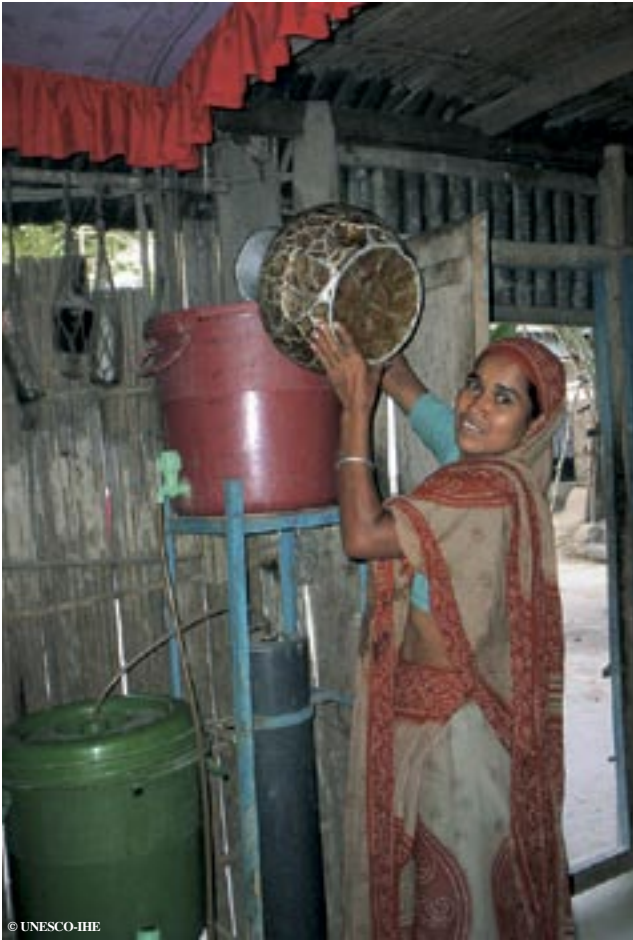
En el hogar de los cinco miembros de la familia Hasan en Bhabanjpur (Raibarij), la Sra. Hassan vierte agua en el filtro familiar para eliminar el arsénico que puede contener. El agua filtrada, para beber o utilizar en la cocina, se depositará en el recipiente verde puesto bajo el filtro
