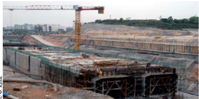
© Ф. Крак Строительство подземной железной дороги в Гуанчжоу, Китай в марте 2008 г.
