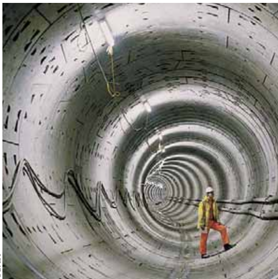
Использование специальной мембраны, наносимой методом распыления (разработка компании BASF) на внутреннюю поверхность стен тоннеля, строящегося в Великобритании, сокращает расход бетона, позволяя экономить миллионы евро на строительных расходах и снижая объем вредных выбросов двуокиси углерода в процессе производства цемента.
