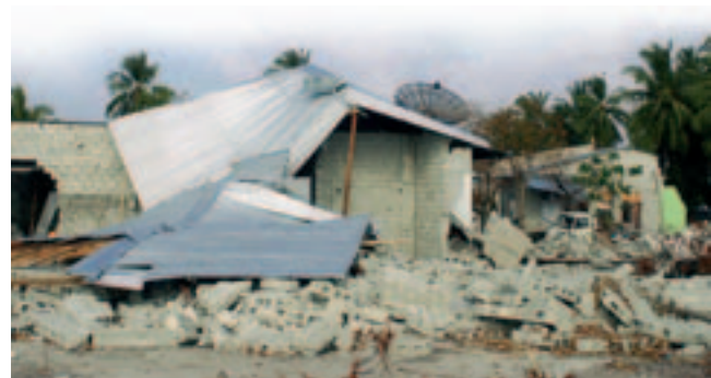
Bâtiments scolaires des Maldives dévastés par le tsunami. Une nouvelle Coalition pour l'éducation veillera à améliorer la sécurité des édifices scolaires face aux catastrophes (voir p. 8)
