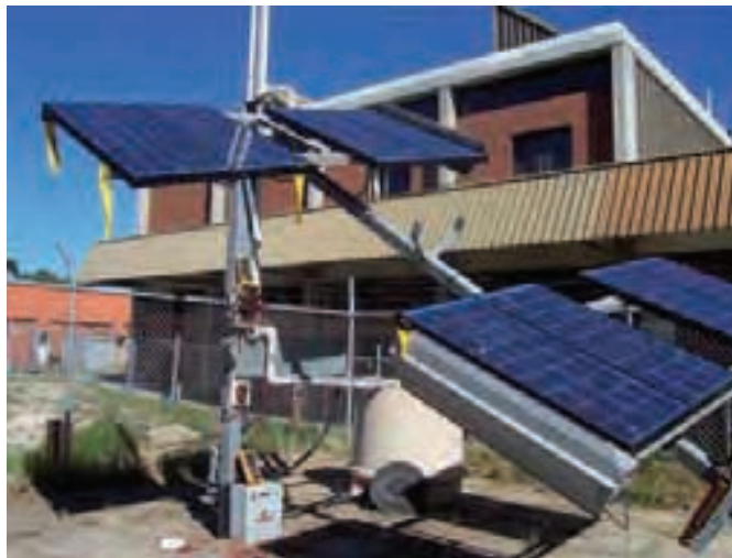
Pembinaan tahun lepas sebuah prototaip sistem kuasa hibrid kekisi - mini yang mencampurkan cahaya matahari, angin dan penjana tenaga mikro-hidro dengan penjana diesel konvensional. Sistem ini akan memberi tenaga dan air bersih kepada masyarakat tempatan di Indonesia.
