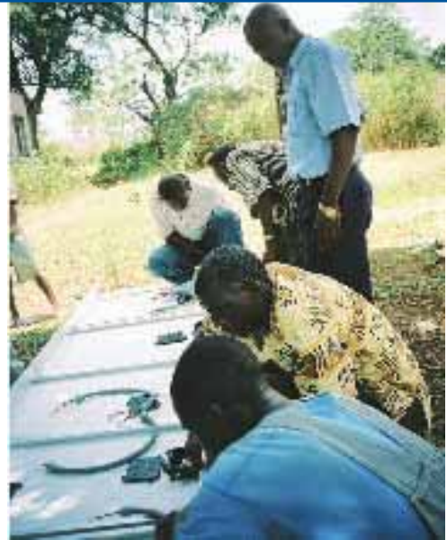
Au cours d'ateliers de formation sur le terrain organisés par l'UNESCO en 2003 à Bamako au Mali, câblage électrique de panneaux solaires et installation de systèmes photovoltaïques par les participants durant les travaux pratiques
