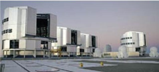
*El observatorio del Monte Paranal, al norte de Chile, está constituido principalmente por el Muy Gran Telescopio de la European Southern Observatory. Consiste en cuatro telescopios de 8 m de diámetro que equivalen a un gran telescopio de 16 m de diámetro. Este instrumento, quizás el más sensible del mundo, realiza desde hace tres o cuatro años observaciones de una calidad sin precedentes*
