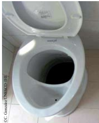
Cette toilette « éco-san » sépare les excréments (à l'arrière) de l'urine (à l'avant) dans deux compartiments distincts, ce qui en facilite le traitement et en abaisse le coût. Des études ont montré que les nutriments contenus dans l'urine humaine peuvent être employés à faire pousser suffisamment d'aliments pour nourrir une personne pendant une journée.
