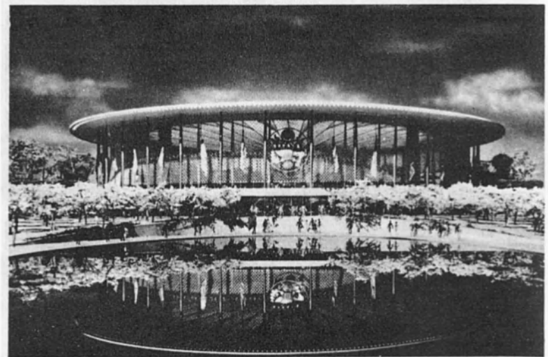
EL PABELLON DE LOS ESTADOS UNIDOS será el más vasto edificio circular del mundo. Estará construido en material plástico y tendrá un techo suspendido sobre columnas de acero.
