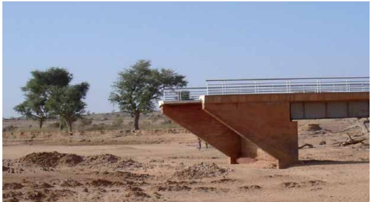
Pont de la route de Bandiagara détérioré lors d'une crue <sup>2</sup>
