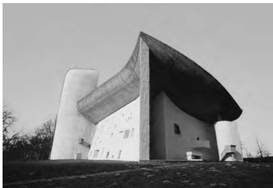
Illustration 10 Vue extérieure de la chapelle de Notre-Dame-du-Haut à Ronchamp, en France, conçue par Le Corbusier et construite en 1950. Le Corbusier fut l'un des principaux pionniers de l'architecture moderne (photo Archivo Iconográfico, S.A./Corbis).
