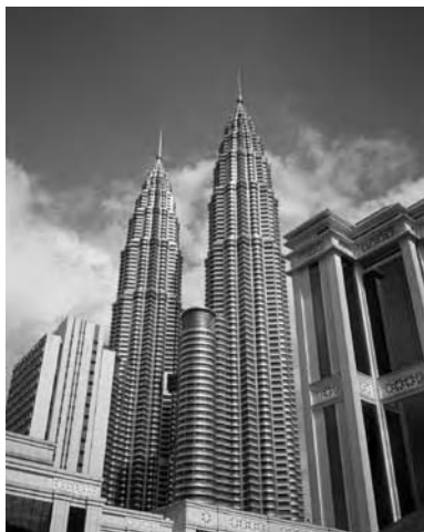
Illustration 91 Les tours jumelles Petronas (1988) de Kuala Lumpur, en Malaisie, hautes de 88 étages, ont été conçues par l'architecte italien Cesar Pelli. Des déchets et matériaux recyclés ont été utilisés pour leur construction (photo John Dakers).
