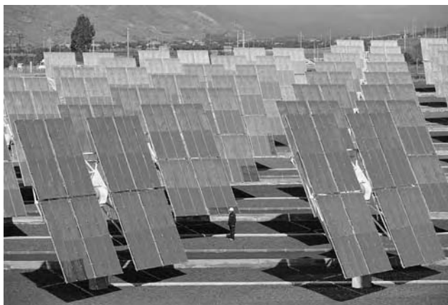
Illustration 92 Centrale Solare Eurelios, une centrale électrique solaire située en périphérie d'Adrano, en Sicile. L'augmentation continue de la consommation en énergie fait de la recherche de nouvelles formes d'énergie renouvelables une priorité absolue (photo DeA Picture Library).
