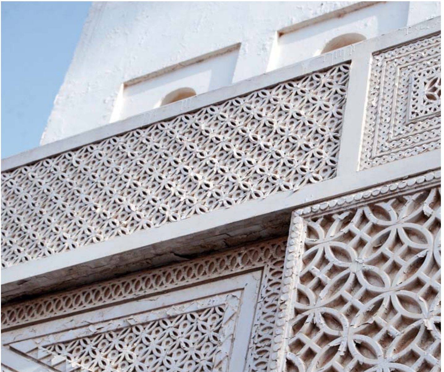
Détail d'un ornement de plâtre sculpté en 1970 sur la façade extérieure de B01 - la porte nord.
