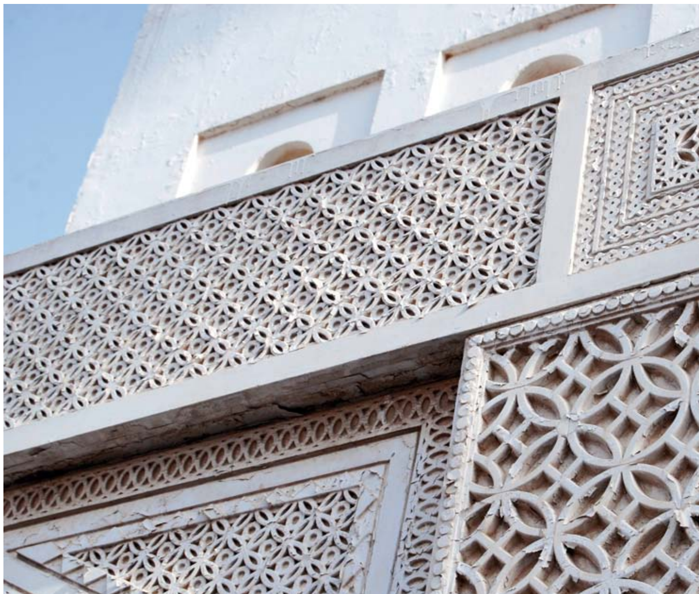
Detalle de un adorno de yeso del año 1970 tallada en la fachada exterior de B01 - la Puerta Norte.
