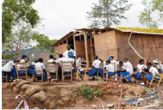
Reconstruindo escolas após o terremoto de 2010, Haiti.
