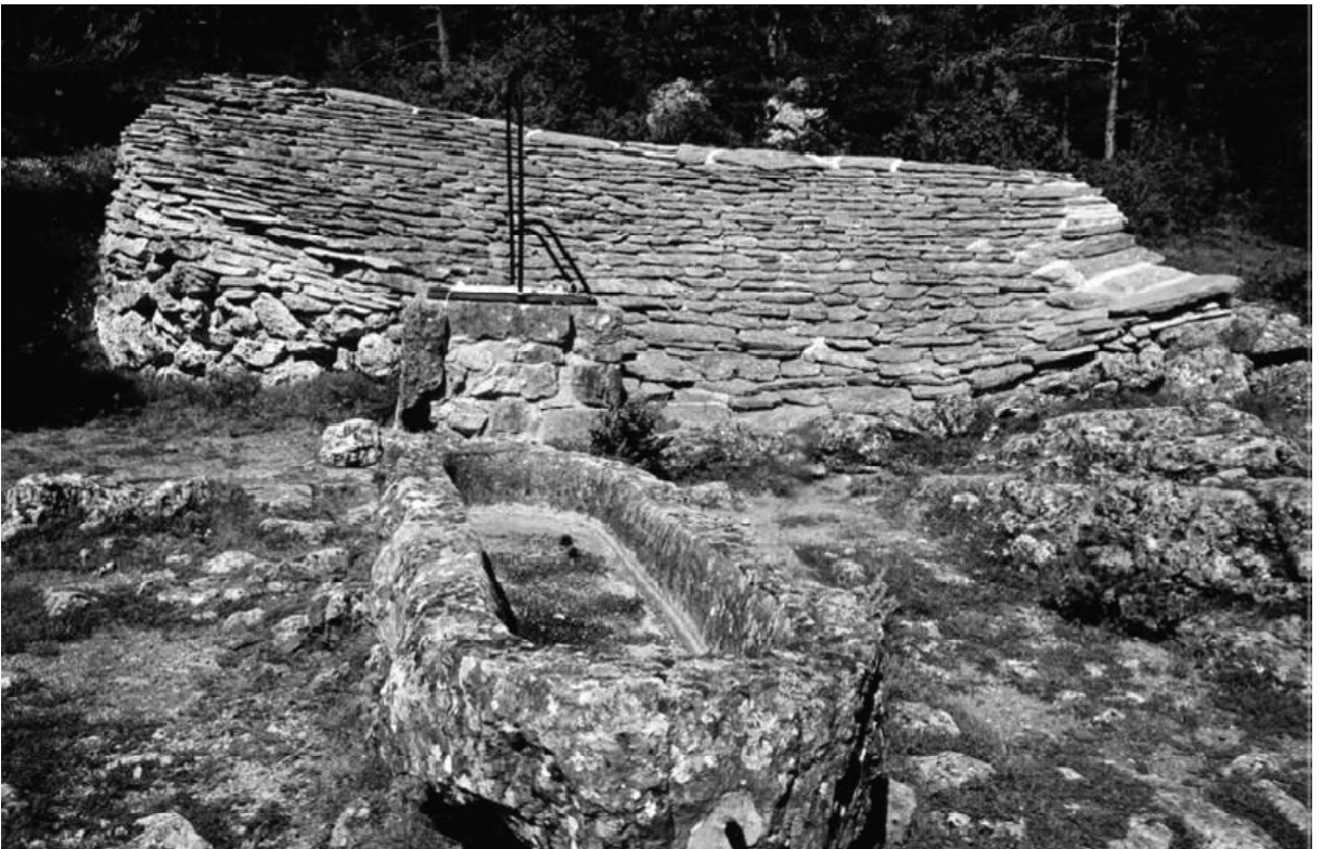
Toit citerne (Saint Jean de Balme)
