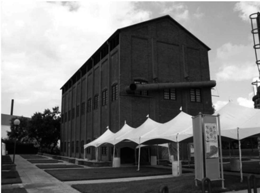
Le bâtiment des compresseurs après restauration
