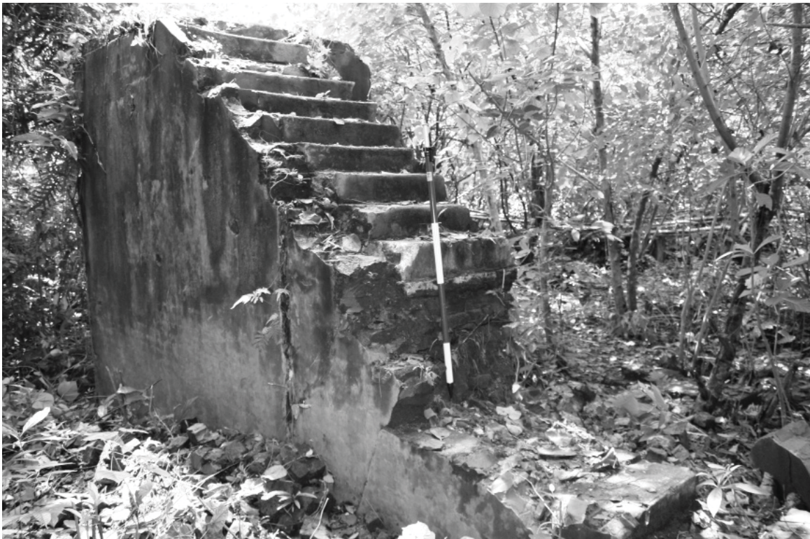
Yap, escalier extérieur à parement de brique et stuc de la maison d'O' eefe
