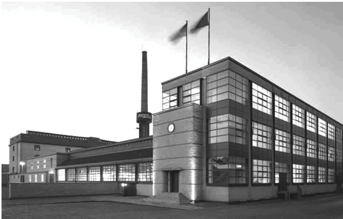
ue sud-ouest du bâtiment principal
