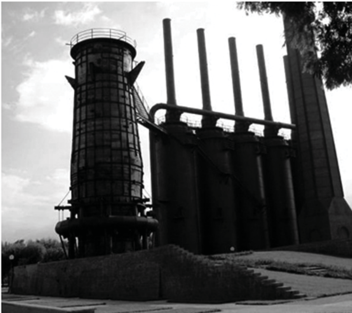
Le haut fourneau n 1 et la batterie de cowers
