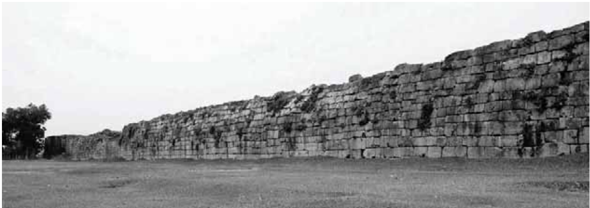
La citadelle intérieure, surface externe du mur nord
