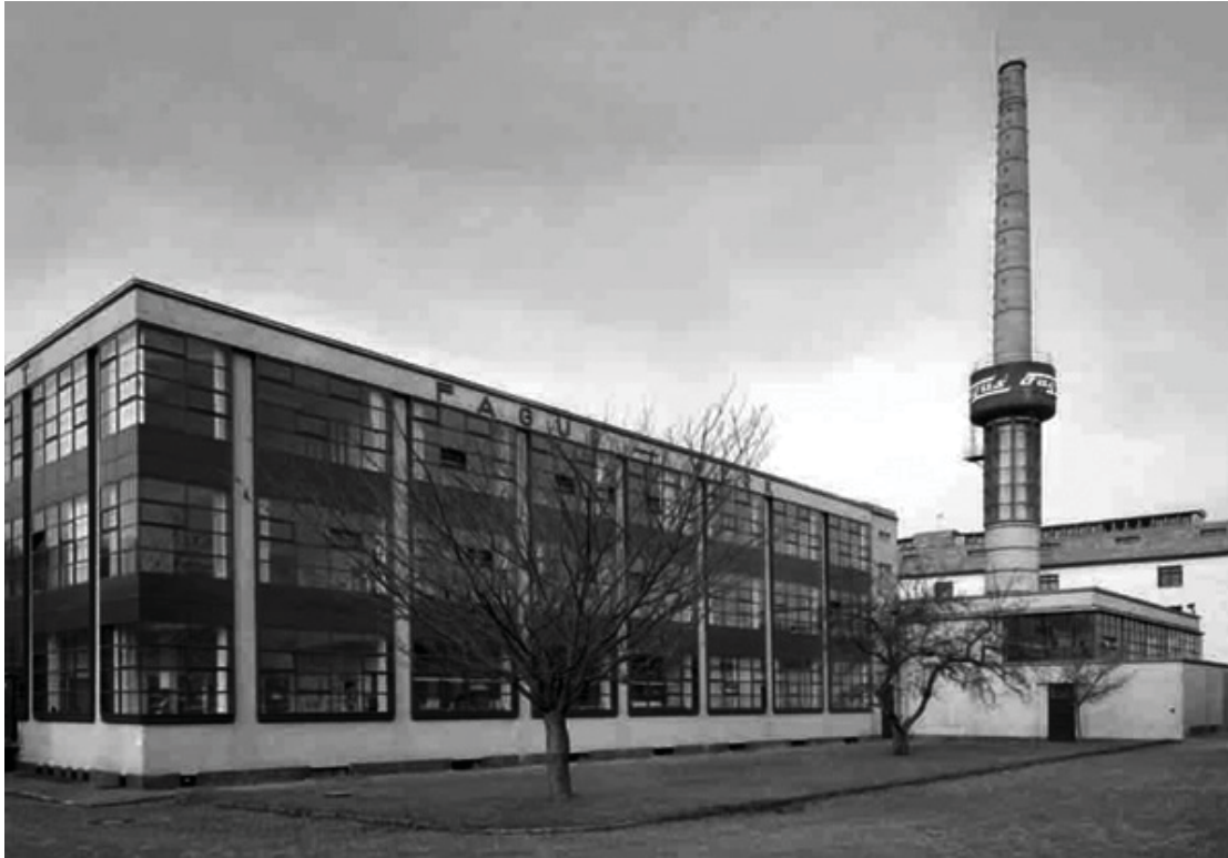
vue sud-ouest générale
