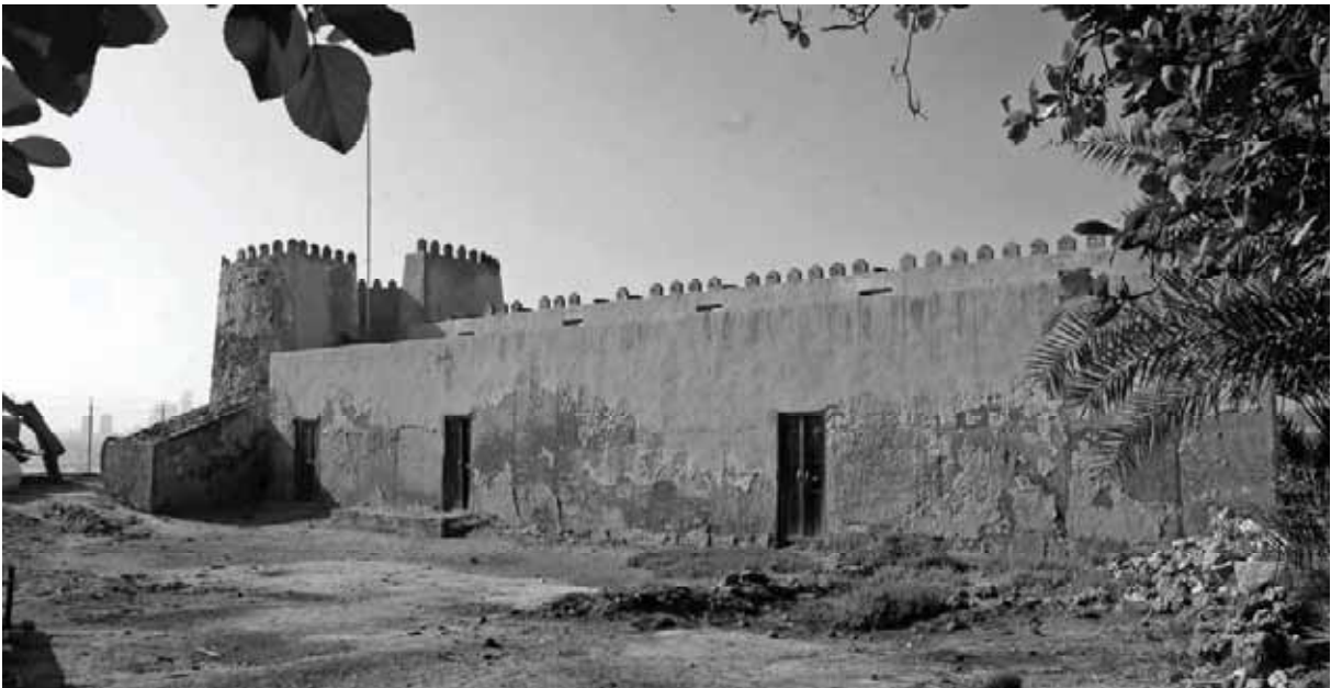
Qal'at Bū Māhir (forteresse de Bū Māhir)
