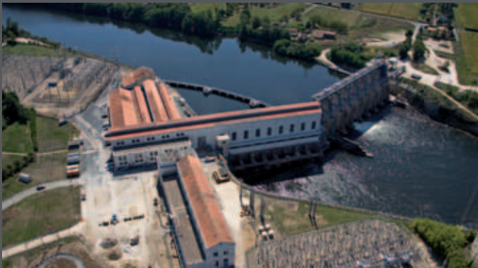
Tuilières dam - © EDF
