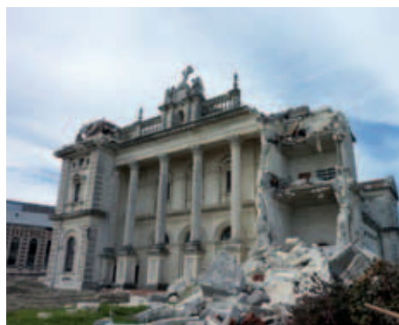
Cathédrale du Saint-Sacrement, Christchurch (Nouvelle-Zélande), après le tremblement de terre de 2011.
