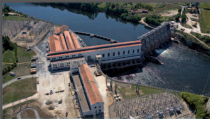
Barrage de Tuilières - © EDF
