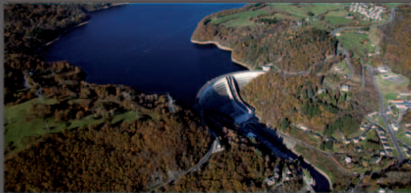
Barrage de Bort-les-Orgues - © EDF
