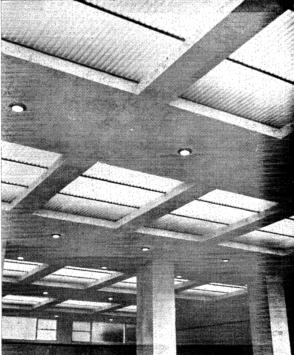
25. MUSEO NACIONAL DE CUBA, La Habana. Système d'éclairage artificiel, panneaux ondulés en matière plastique (Vinyl) complétés par des réflecteurs orientables, équipés de lampes à incandescence.
