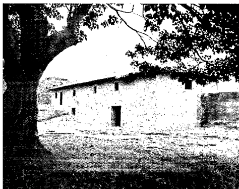
55. PALAIS DE GUÉZO, Abomey. Case à étage ( singbo ) du roi Guézo. L'aspect extérieur est semblable à celui des bâtiments en banco . Une couverture de chaume devrait compléter le placage en tôle de la toiture.
