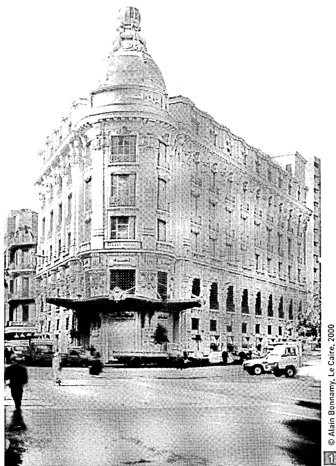
63. Grand magasin Omar Effendi, rue Abdelaziz, de l'architecte Raoul Brandon, 1923.
