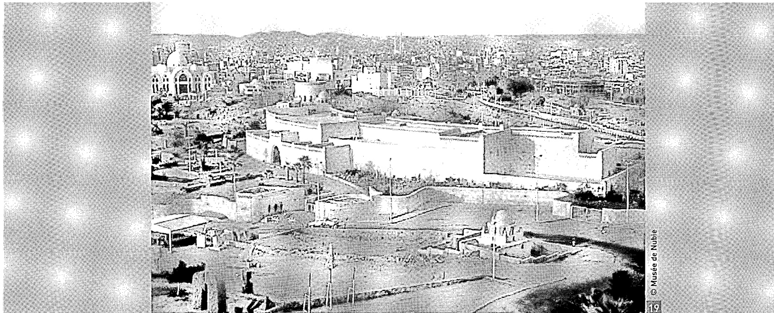
19. Le musée de Nubie a été édifié avec le soutien de l'UNESCO et sous sa supervision, en intégrant des éléments du patrimoine culturel nubien dans son architecture
