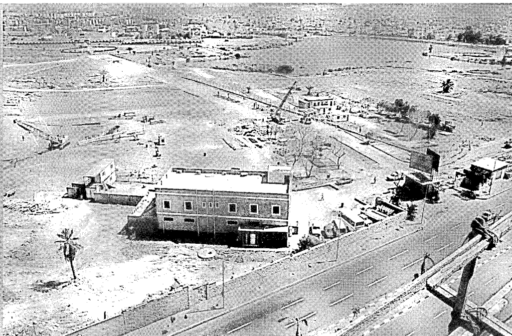
7. Vue d'ensemble du chantier du NMEC, des fouilles archéologiques et des complexes provisoires pour le personnel avec les laboratoires de conservation, El-Fustat, Le Caire
