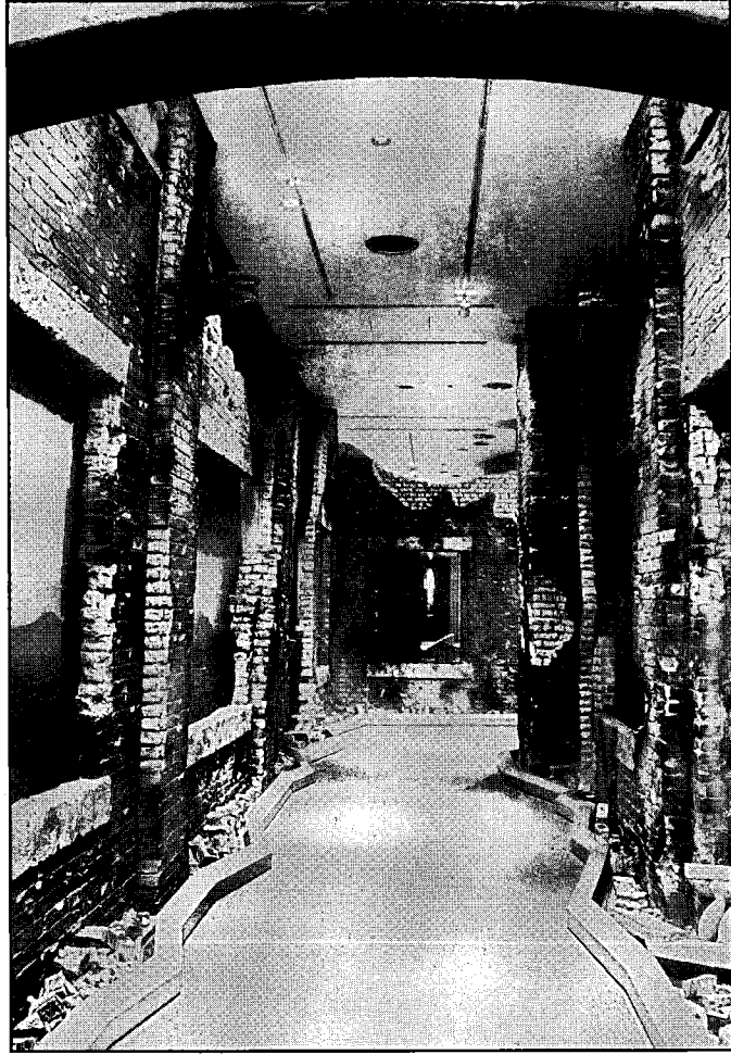
في الصورة نرى «نموذج المدينة المحطمة» حيث أنشأت نماذج تحاكي المباني المهدمة بالقرب من مركز الانفجار ، وذلك بعد القاء القنبلة الذرية مباشرة .
