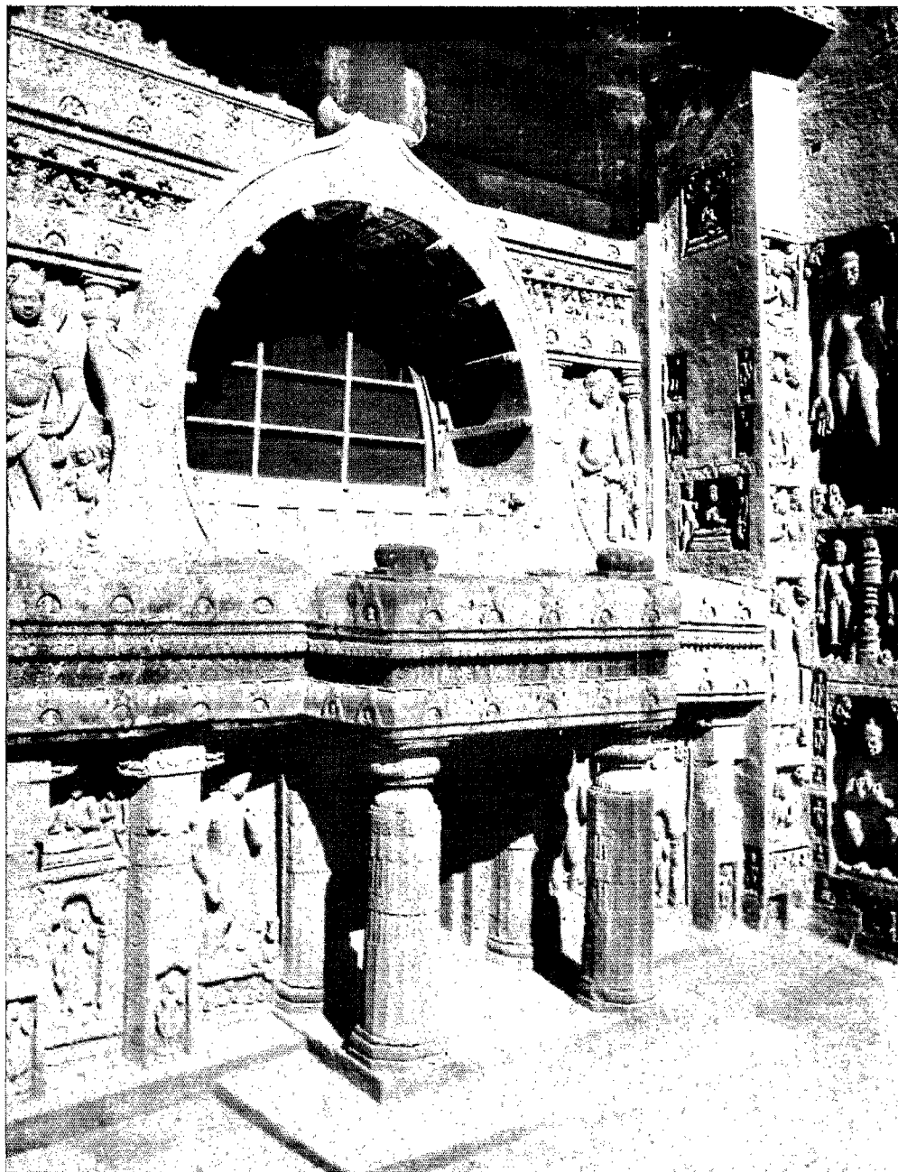
73. Ajanta. Façade sculptée très caractéristique montrant la persistance des techniques du bois dans les constructions de pierre.
