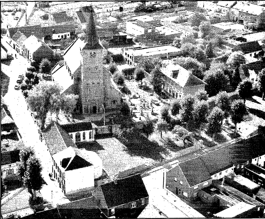
Vue de l'église Saint-Laurent, construite vers l'an mille, l'une des églises du haut Moyen Age le mieux préservées de Belgique ; le bâtiment du XIX e siècle, au premier plan, abritera le musée provincial du parc archéologique.
