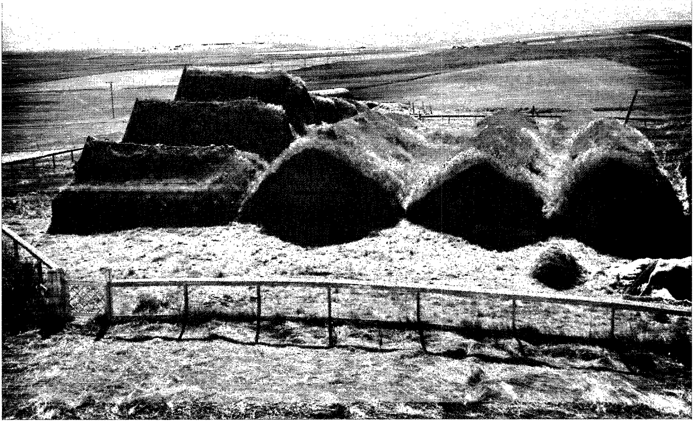
11 La granja de Glaumbaer, construida entre 1840 y 1880, es un buen ejemplo de la técnica de recubrimiento con césped. Los gabletes de la izquierda son las únicas estructuras de madera visibles desde el exterior. La granja pertenece al Museo Nacional y alberga al museo local.
