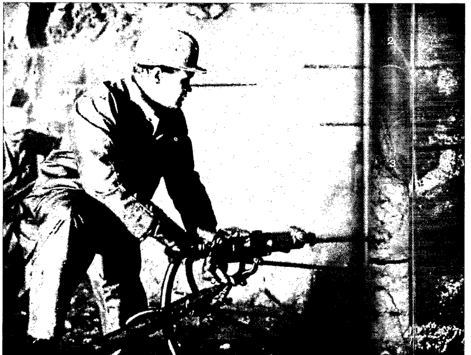
62 Échantillons extraits du sol pour l'aménagement d'une ligne souterraine du métro, exposés au voisinage de photographies du chantier.
