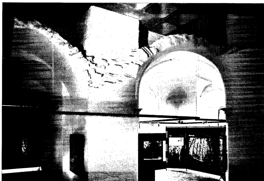
13 La salle de la tour nord-ouest. Les saillies ont été reconstruites. Dans la partie antérieure, où la voûte était détruite, on a bâti un plafond en béton caissonné.
