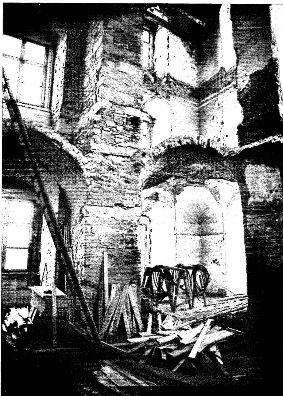
12 La Willibaldsburg; sala de la torre noroeste antes de la restauración.
