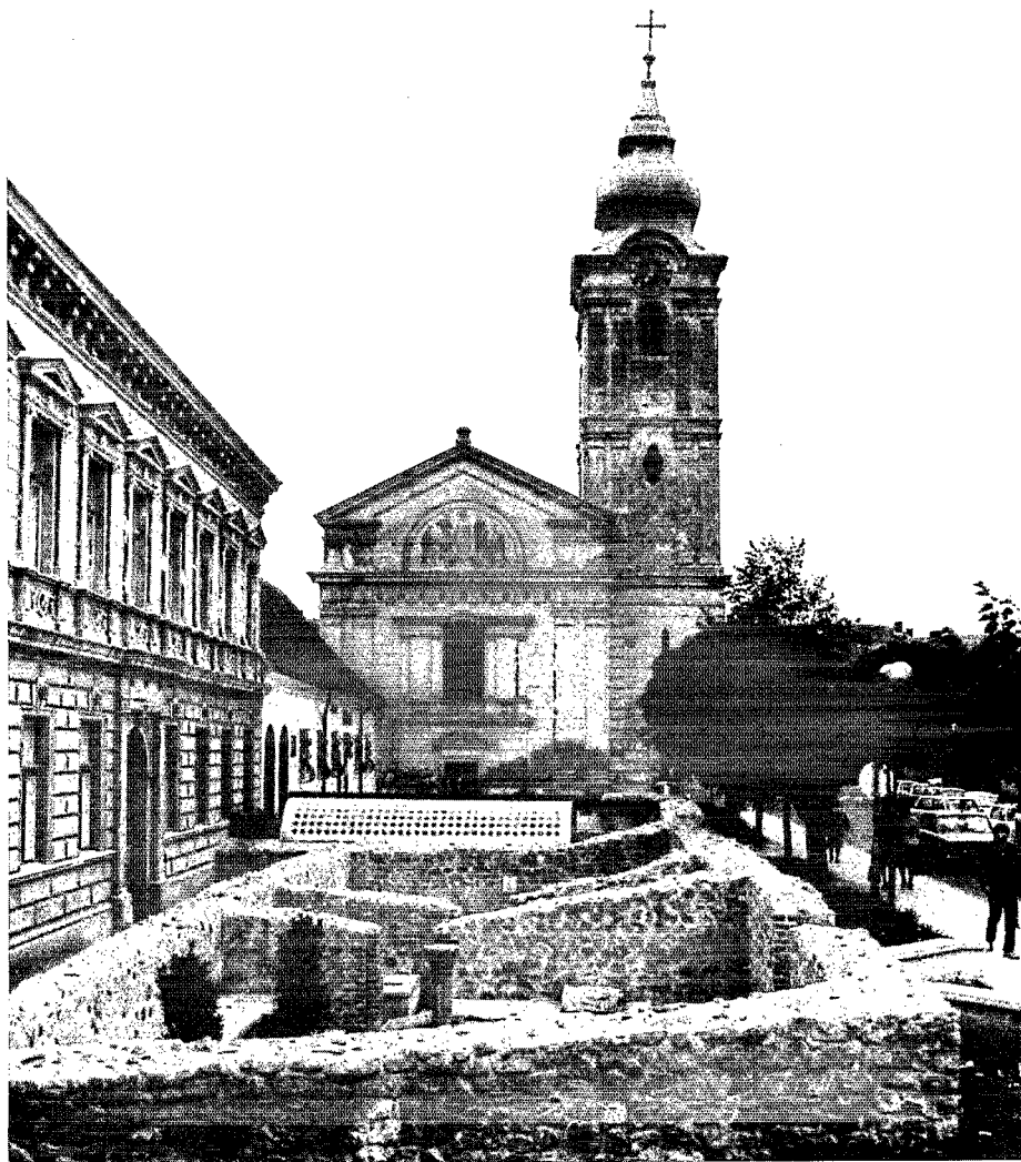
Pécs. Les ruines des bains turcs dans le centre de la ville.
