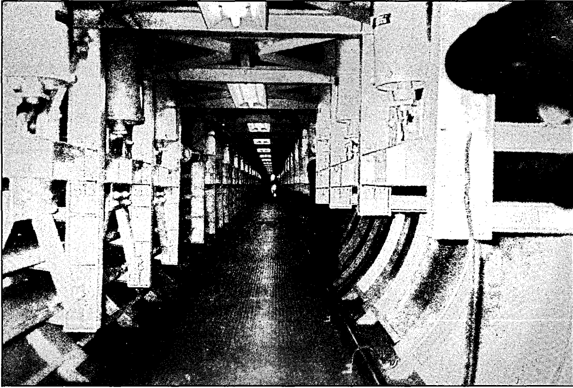
ممر للأسلاك طوله ٦٠ مترا، على عمق ١٠ أمتار تحت سطح الأرض، يربط مركز التحكم في الإطلاق بخزانة القذيفة التي يبلغ عمقها ٤٤.٥ مترا.
