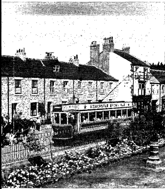
5 Vue partielle de la reconstruction d'une rue urbaine des années 1920 à Beamish.
