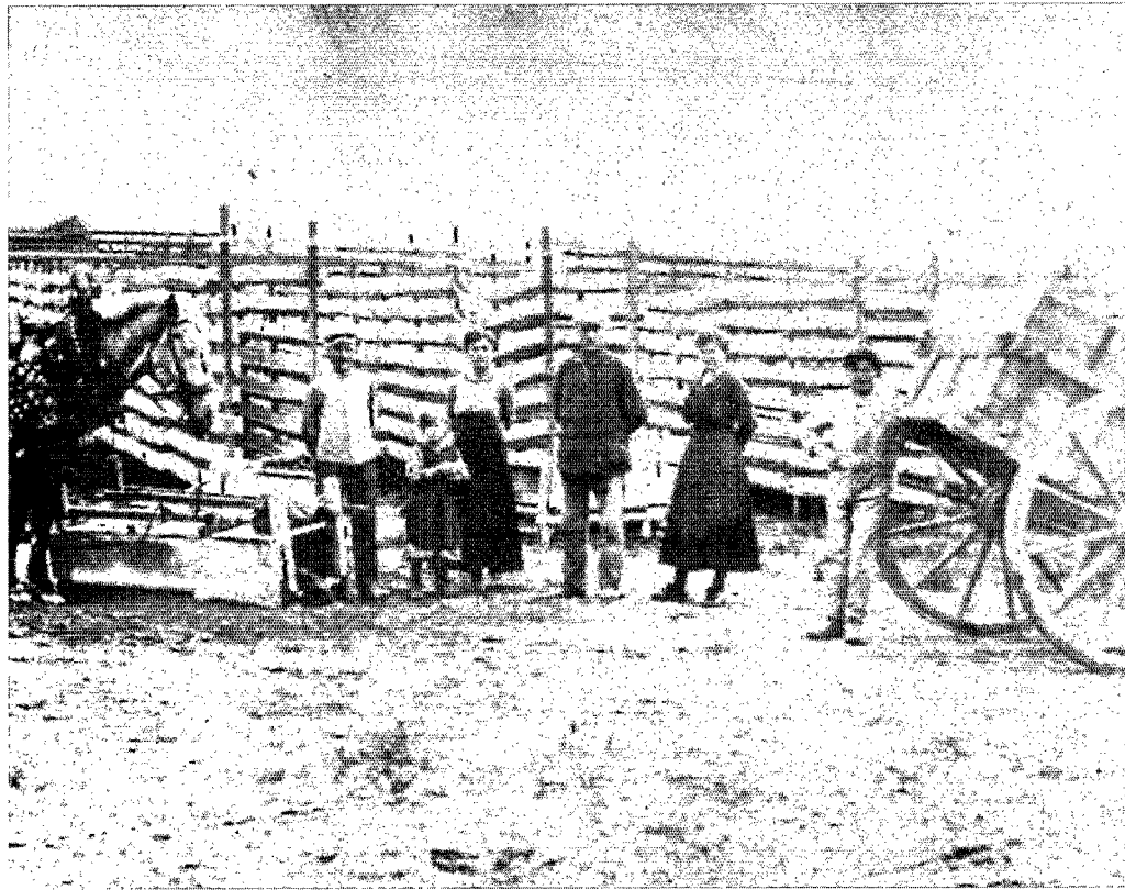
25 Fabrique d'aggloméré de ponce aux environs de 1900. Transport des blocs dans des tombereaux tirés par des chevaux et séchoirs.
