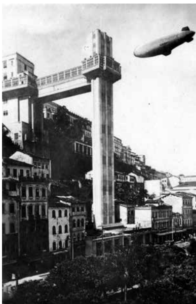
Elevador Lacerda, Ingeniero Thiers Flemming, Prentice & Floderer, 1929. Archivo Hugo Segawa.
