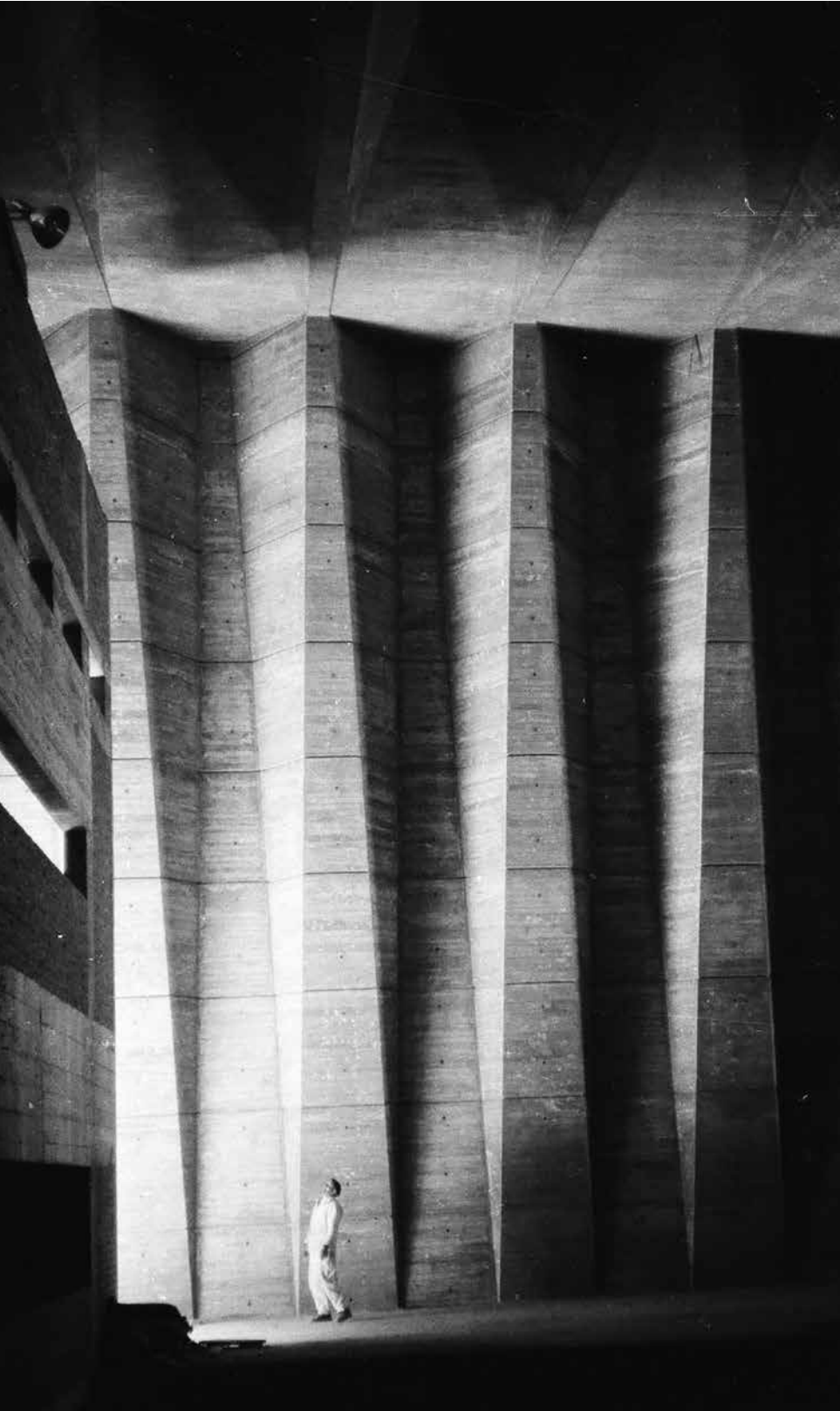
Detalle del interior, en el que se observa el uso estructural y estético de los materiales de la Sede de la UNESCO. Archivo de la UNESCO, París.
