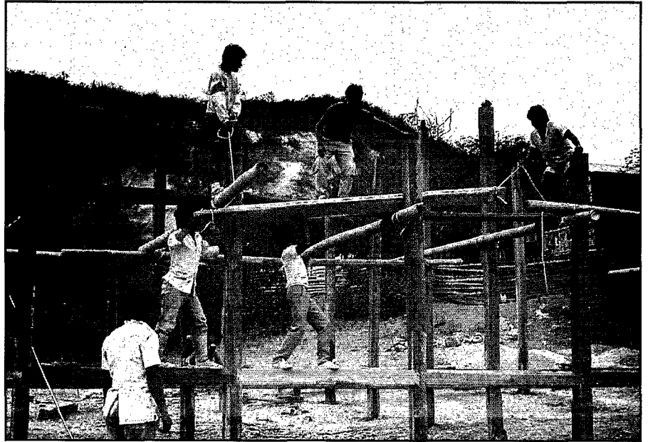
Des constructeurs au travail.
