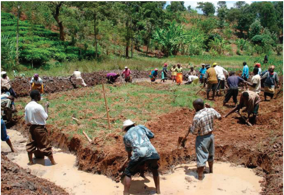
Photo 6: Participation communautaire pour la construction d'un bassin piscicole pour le réseau forestier de Thuita
