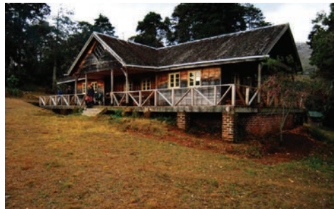
Figure 5: Chalet de montagne construit à partir de bois de cèdre de Mulanje
