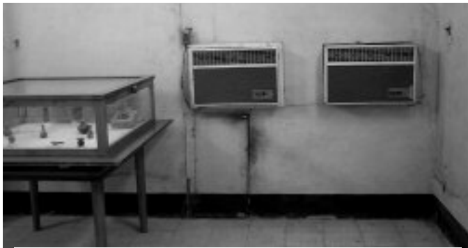
Figure 16. Petit musée typique avec des climatiseurs modernes omniprésents. Ceux-ci procurent souvent autant de dommages aux artefacts que de confort pour les visiteurs et le personnel. Ils entraînent souvent une humidité relative élevée et des sources de condensation.
