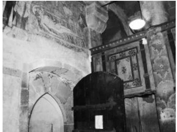
Installation de détecteurs de mouvement dans un intérieur d'époque Photo : Pavel Korda
