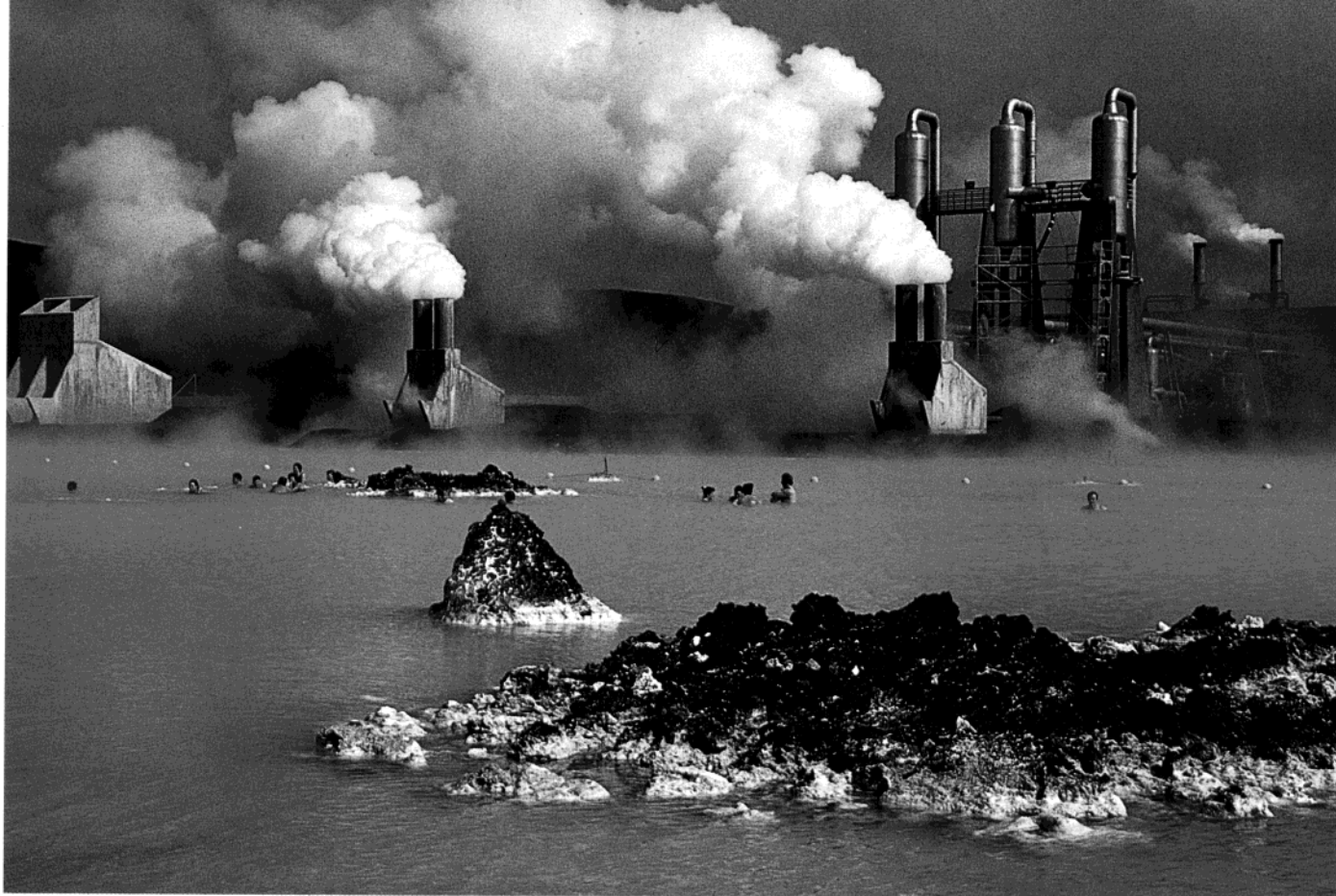
La central geotérmica de Svartsengi, que surge a Reykiavik de agua caliente. Al vaciarse su excedente en un campo de lava nació una laguna artificial, la Laguna Azul, cuyas aguas ricas en minerales se mantienen a una temperatura que fluctúa entre 25 y 35°C.
