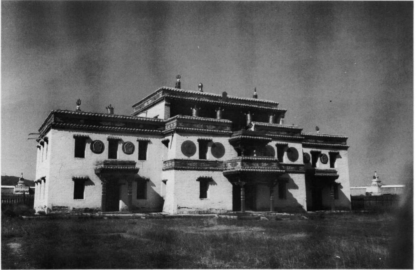
Le temple de Labrang est situé dans la vaste enceinte du monastère de Erdenidzou, haut lieu architectural et culturel de Mongolie, à 400 km environ à l'ouest d'Oulan-Bator, la capitale. De style tibétain, datant de 1780, cette massive construction à léger fruit, au toit plat et aux fenêtres en trapèze était à la fois la résidence du Lama et un lieu de culte.
