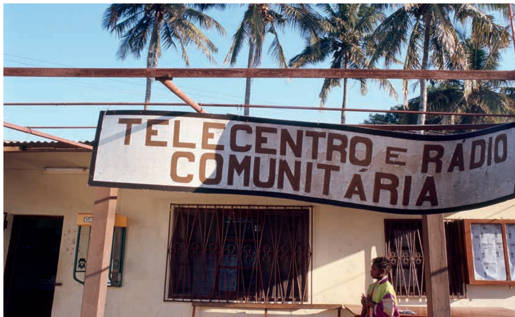
Vue de la façade du Centre multimédia communautaire de Manhica (Mozambique).
