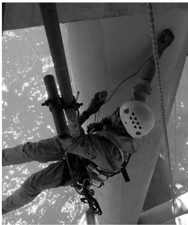
© Paula West, Australia 在钢管上进行工程测试修理
