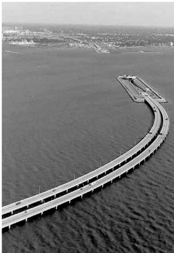
© SAICE 美国 Monitor Merrimac 纪念桥隧道
