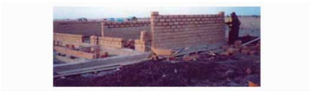
© S. Mwangi 在黑心棉土壤中,用混凝土柱支撑的钢筋地梁地基
