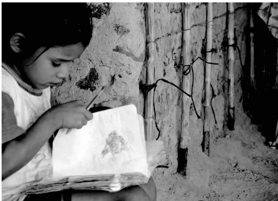
© Stephen Jones EWB - UK 竹墙钢筋减少了在地震中坍塌的风险,拯救了生命
