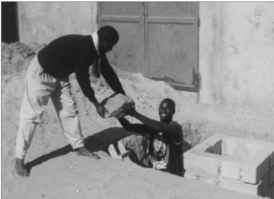
Réalisation de puisards dans un quartier de Yeumbeul (Sénégal) © G. Domenach-Chich
