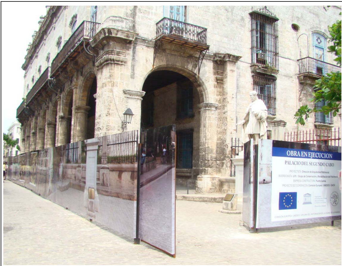
Comienzo de las obras de restauración del Palacio (2010)
