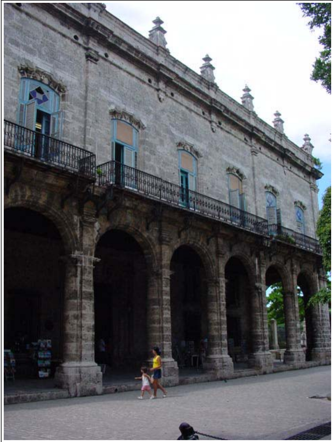
Fachada principal del Palacio previa a la actual restauración
