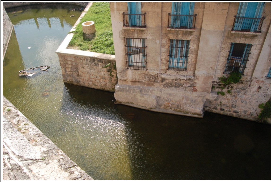
Foso del palacio. Recuperación llevada a cabo en los años sesenta
