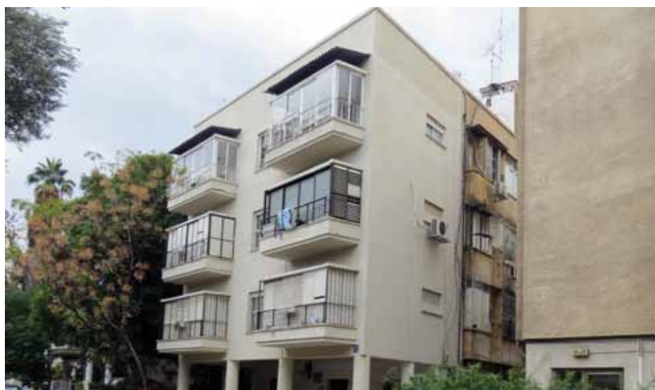
Les colonnes de type pilotis qui élèvent les bâtiments au-dessus de la rue ont été utilisées par Le Corbusier.
