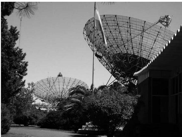
**Fig. 4** - El Instituto Argentino de Radioastronomía (IAR) dependiente del Conicet, dispone de dos antenas de 30 m y puede operar en diversas frecuencias entre 1,4 y 5 GHz. La antena 2 fue utilizada regularmente para hacer el relevamiento de todo el cielo del hemisferio sur, buscando señales de origen artificial con una resolución espectral de 0,05 Hz y una sensibilidad de  $10^{-24} \text{ Wm}^{-2}$ . Foto: G.A. Lemarchand.
