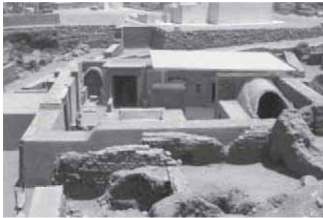
Рисунок 2. Простая крыша, построенная над важной частью археологических раскопок возле музея. Обратите внимание на едва уловимый уклон и желоб для удаления дождевой воды от охраняемой зоны и исключения проблемы сырости на стенах. Небольшая цена, большой эффект предохранения. Все фотографии в данной главе сняты автором, Стефаном Мичальски, сотрудником Канадского института консервации. Все, кроме 9 и 10, сняты во время учебных или консалтинговых проектов ЮНЕСКО или ИКОМ в Каире, Асуане и Кувейте в период с 1986 по 2002 г.
